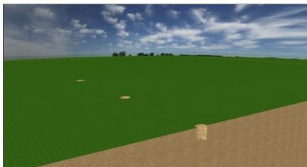
1 Marque os pontos onde serão fixados os mourões (postes de concreto, madeira, tubo ou qualquer outro perfil), os buracos devem ter pelo menos 50cm de profundidade e distâtes entre 2,00 a 2,50m.
